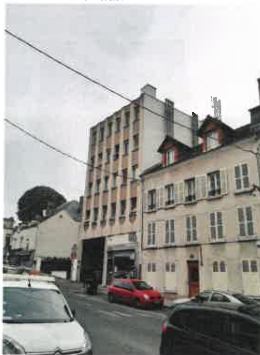
Photographies : Vue 1- Avant Travaux
