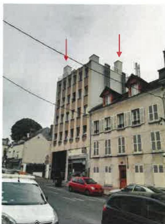
Photographies : Vue 1- Après Travaux
